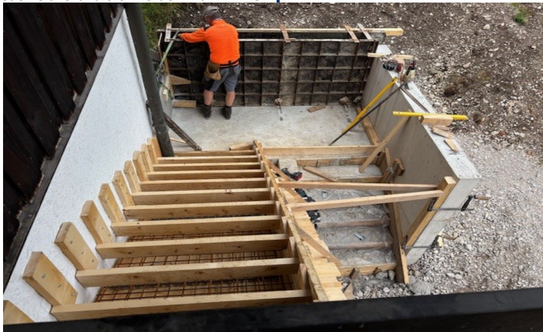
Bau der neuen Fluchttreppe
